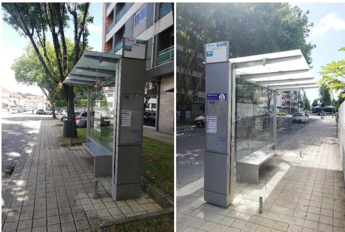
Fig. 129 Exemplos de paragens de autocarro no Porto (abrigo tradicional e invertido)
