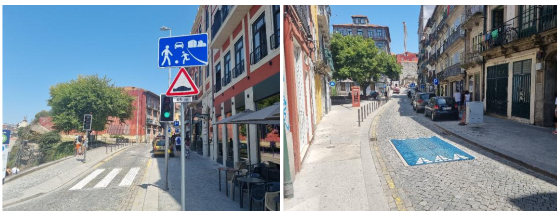
Fig. 107 Exemplo de zona de coexistência incorretamente aplicado na Rua Chã
