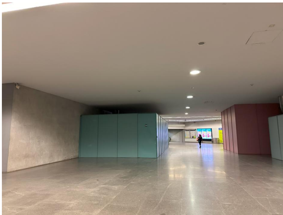
Fig. 187 Interface do Marquês – Átrio da Estação de Metro
