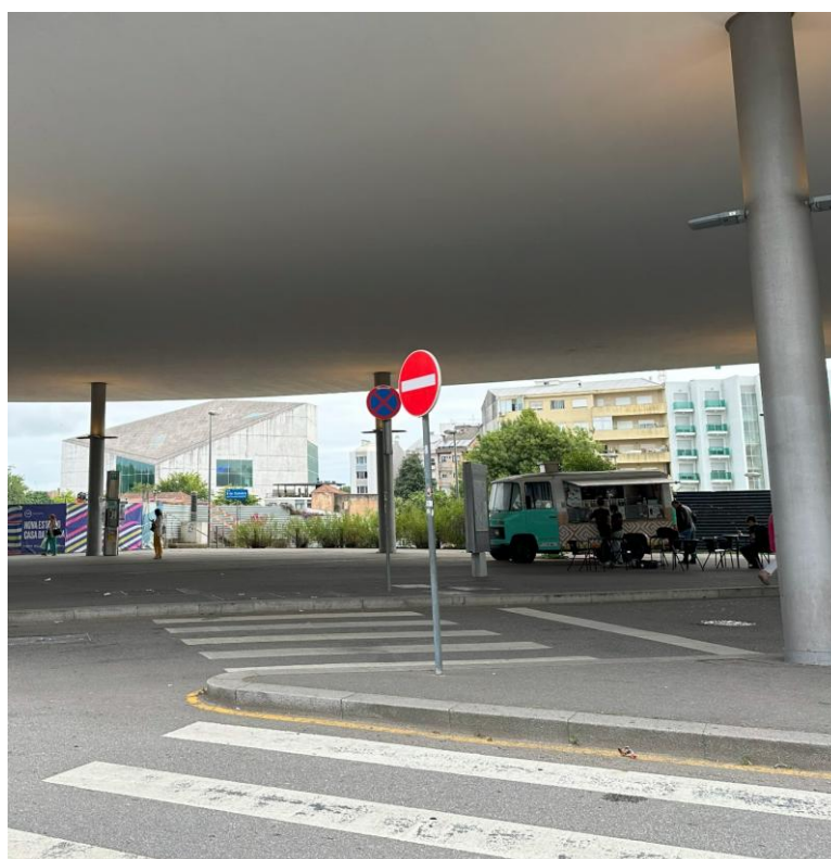
Fig. 179 Interface da Casa da Música - Passadeiras sem rebaixamento
