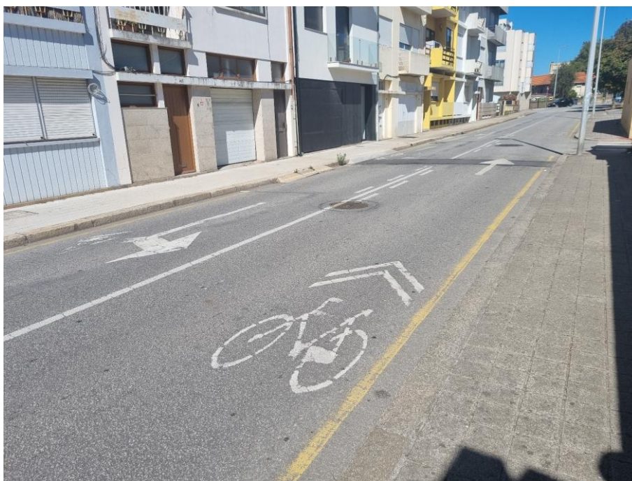
Fig. 216 Ciclovía em via banalizada na Rua do Lugarinho
