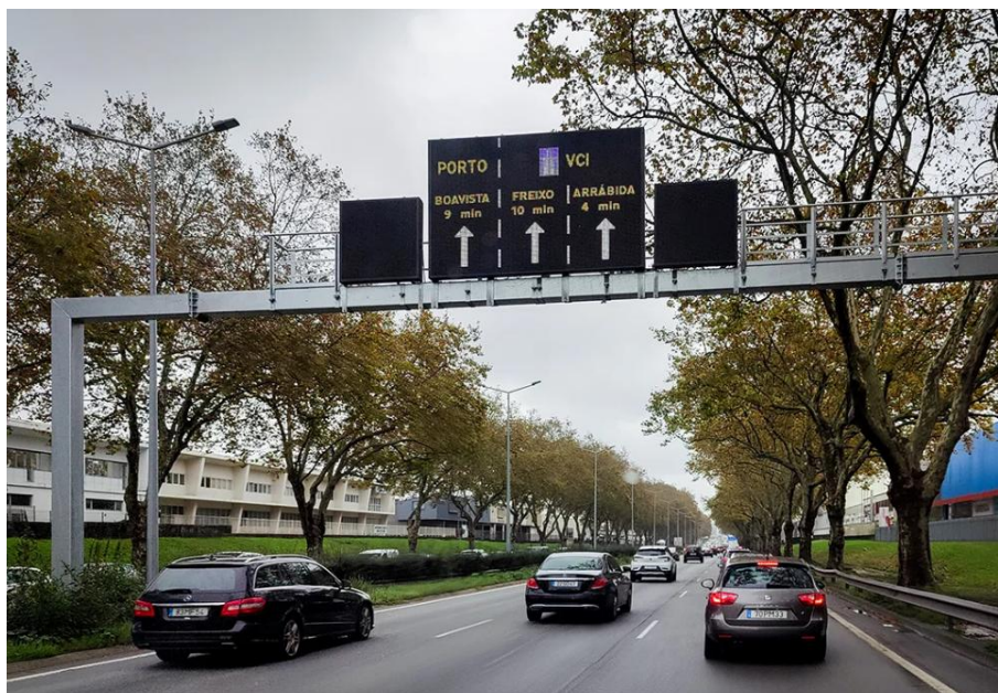
Fig. 116 Painel de mensagem variável na Avenida AEP
