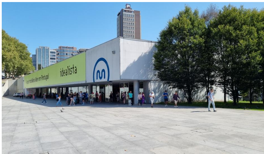
Fig.198 Interface da Trindade – estação de metro
